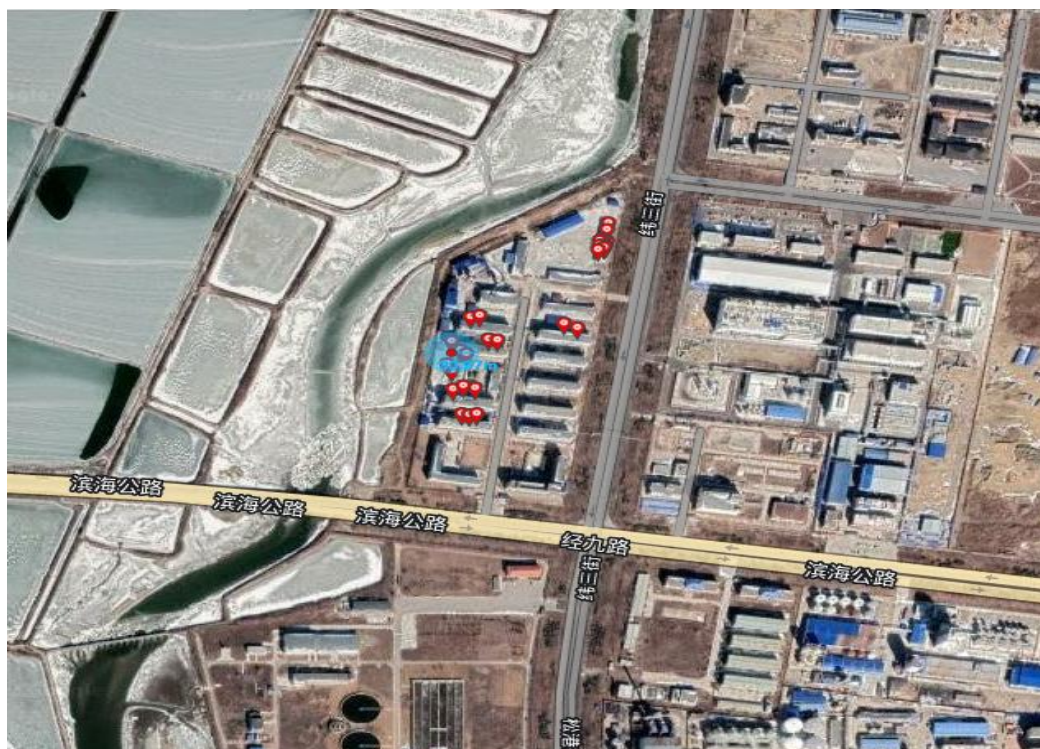
当目标装置类型为压力容器时半径为 37.439 米，模拟图如下
